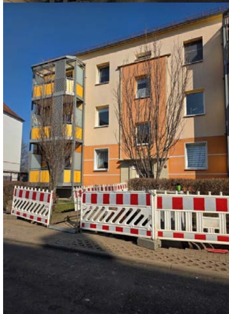
oben: Bauarbeiten in der Kohlstockstraße 1–13 zur Erneuerung der Gebäudezuleitungen
