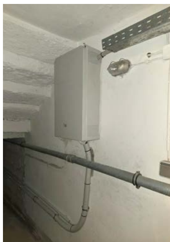
unten: Eindrücke von den Baumaßnahmen zur Erneuerung der Hausanschlusskästen und Gebäudezuleitungen
