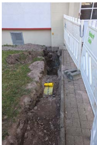
unten: Eindrücke von den Baumaßnahmen zur Erneuerung der Hausanschlusskästen und Gebäudezuleitungen
