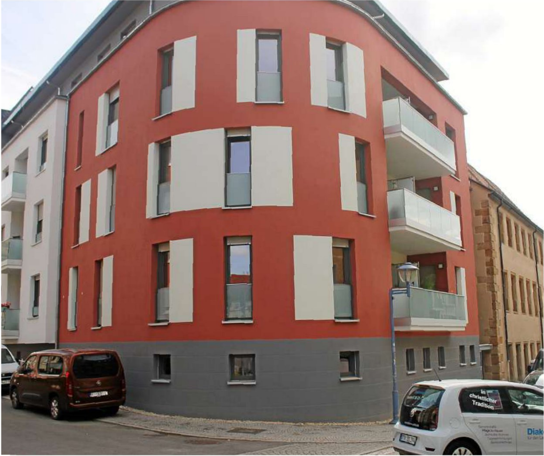
Die Wohnungsbaugenossenschaft Gotha (WBG) hat das Amtshaus Augustinerstraße 13/15 saniert und um dieses rostrote Eckgebäude erweitert.
