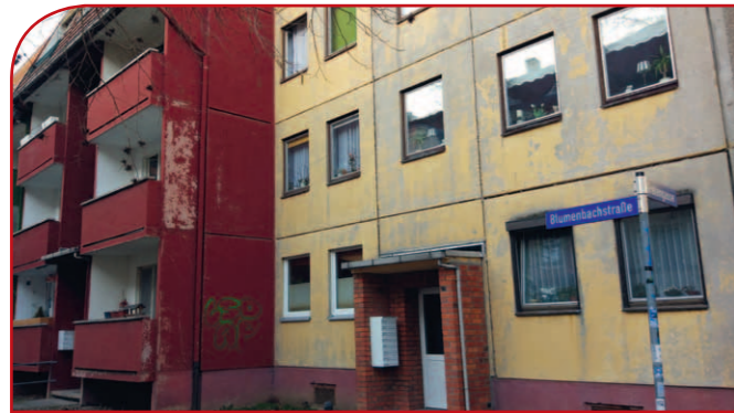
Blumenbachstraße 2, 4, 6, 8 im alten Zustand ...
