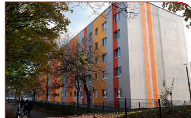
Neue Fassade in der Otto-Geithner-Straße 19-33.
