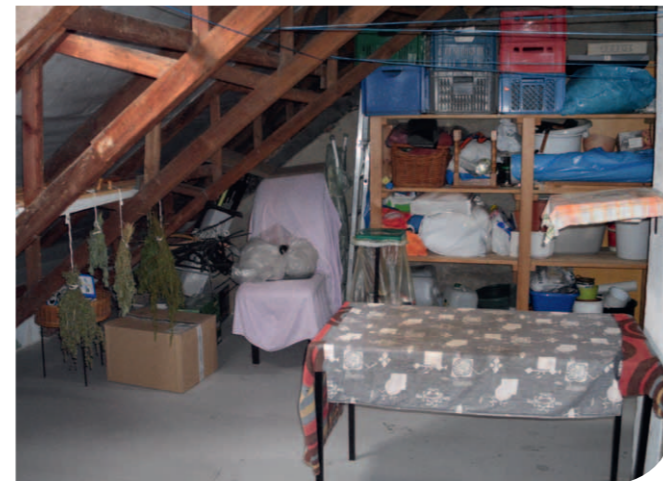
Sperrmüll auf dem Dachboden - Im Ernstfall eine echte Gefahr
