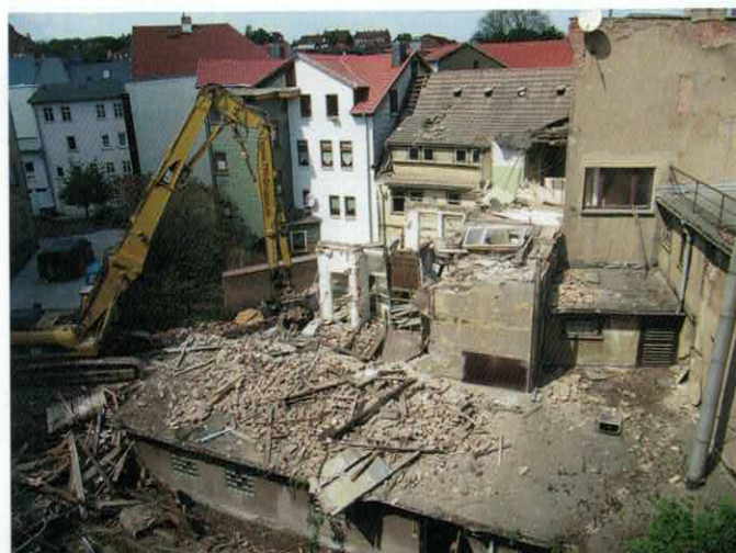
Bild 3. Abriss der historischen Gebäude
