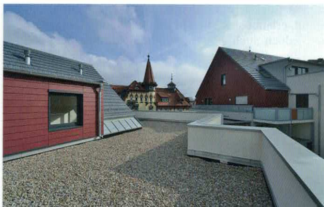
Bild 8. Eine der großzügigen Dachterrassen des Neubaus
