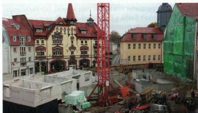
Bild 4. Die neue Wohnanlage wächst in Gothas Innenstadt
