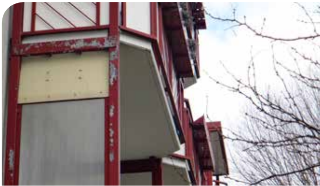
Romillystraße 7-11 Beschichtung der Balkon- und Hauseingangsstahlkon- struktion, Umbau der Balkonentwässerung
