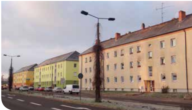
Enckestraße 12/14 Dachsanierung, Abtragen alter Schornsteine, Fassaden- sanierung
