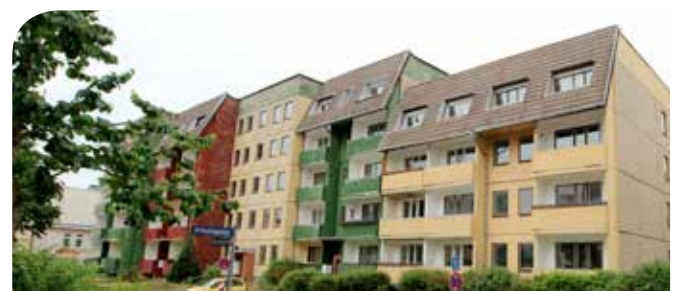
Bestand vor der Sanierung
