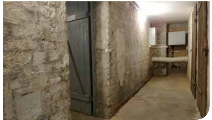
Straße der Einheit 25-31 Instandsetzung Keller (Wände und Böden)
