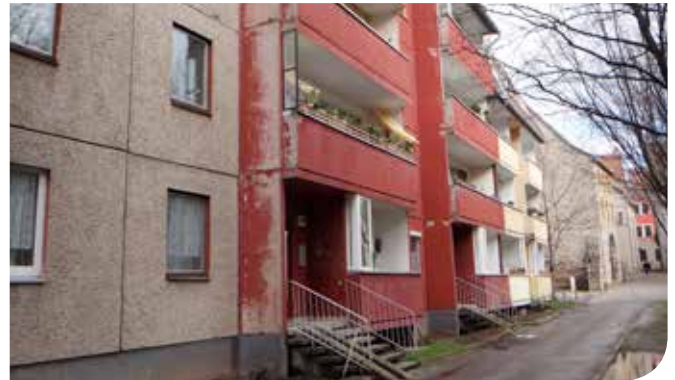
Hützelsgasse 6/8/10 Erneuerung Fenster, Sanierung Fassade und Hützelsgasse 8 Balkonanbau
