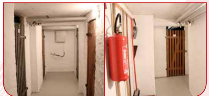
Instandsetzung Keller (Wände und Böden)
