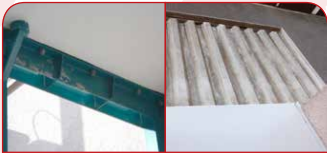
Dr.-Hans-Loch-Straße 1 bis 5 – Zustand vorher
