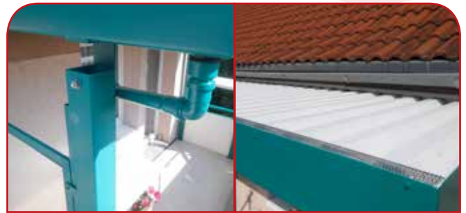
Beschichtung der Balkon- und Hauseingangsstahlkonstruktion, Umbau der Balkonentwässerung
