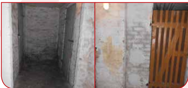
Straße d. Einheit 12 - 16 – vorheriger Zustand des Kellers
