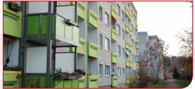
nach der Sanierung der Fassade und der Erneuerung der Fenster
