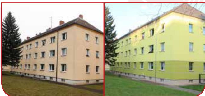
Enckestraße 16, 18 - vorher/nachher Ansicht
