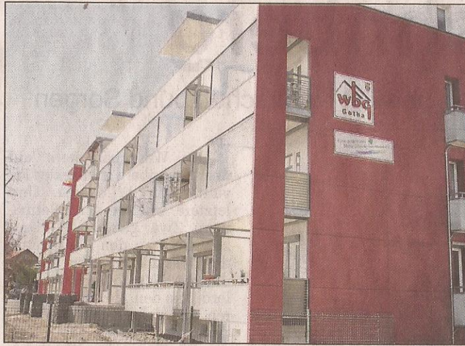
Die Sanierung der Wohnanlage Bohnstedtstraße durch die WBG ist fast abgeschlossen. Foto: Wenzel
