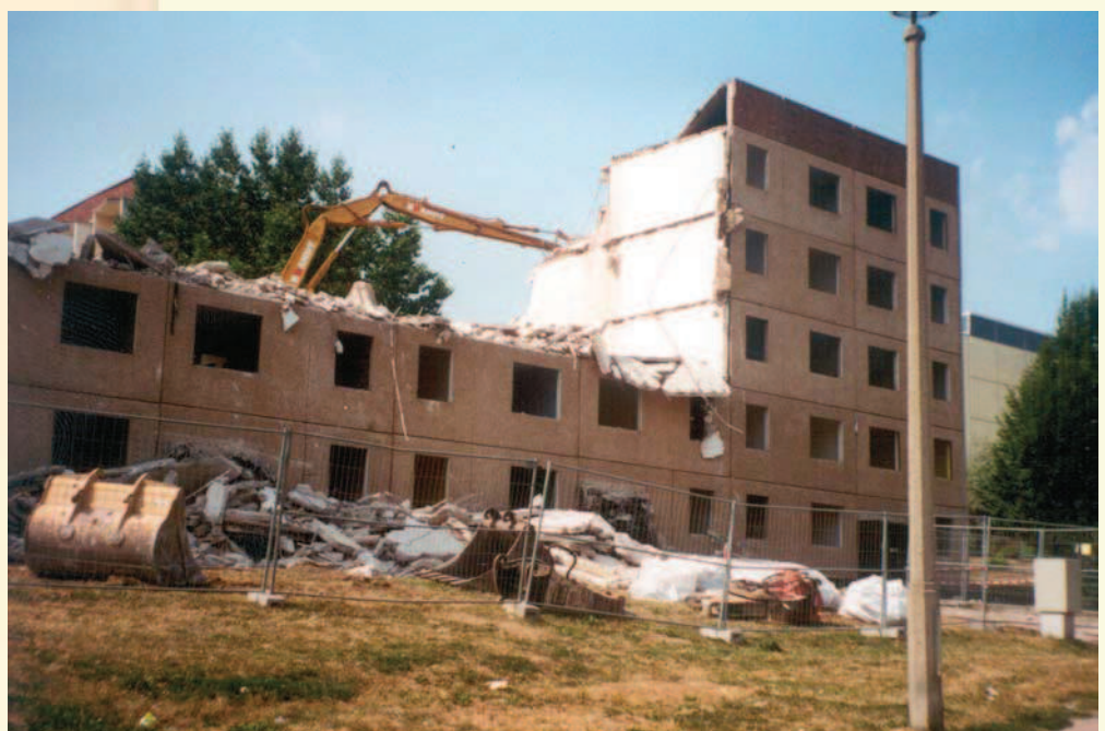
Abriss der Wohnblöcke "An der Goth 1-7" Foto: Archiv WBG
