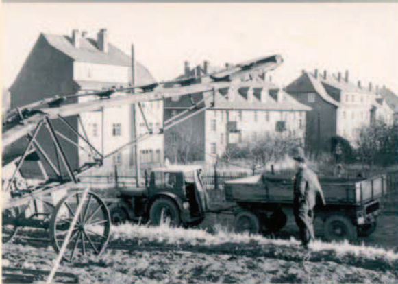
Bau der Häuser in der Kantstraße AWG "Deutsche Post" Foto: Martin Karstedt
