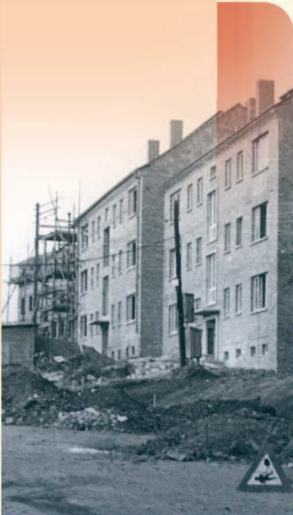
Bau der Häuser in der Kantstraße AWG "Deutsche Post" Foto: Martin Karstedt
